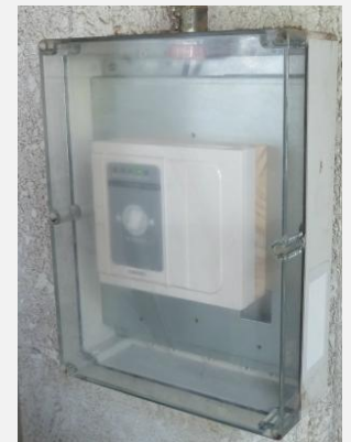
センター3F非常階段側入口
