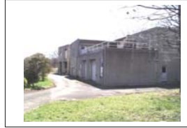
廃液処理施設
