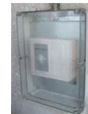
センター3F非常階段側入口
