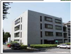
センター事務室 ・機器室 (3, 4F)
